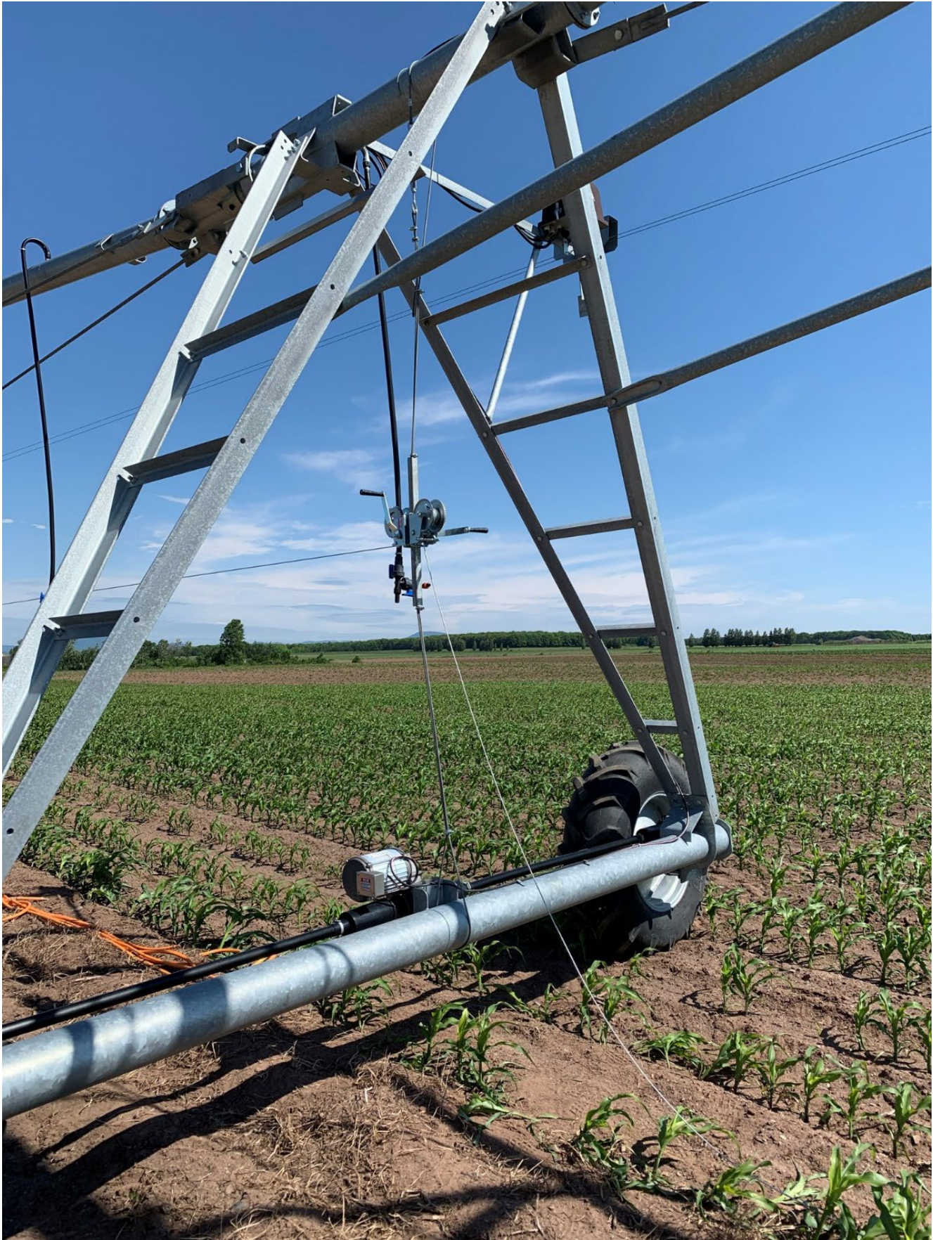
Figure 16. Montage du système de câble d'acier sur la structure du pivot existante avec treuil.
