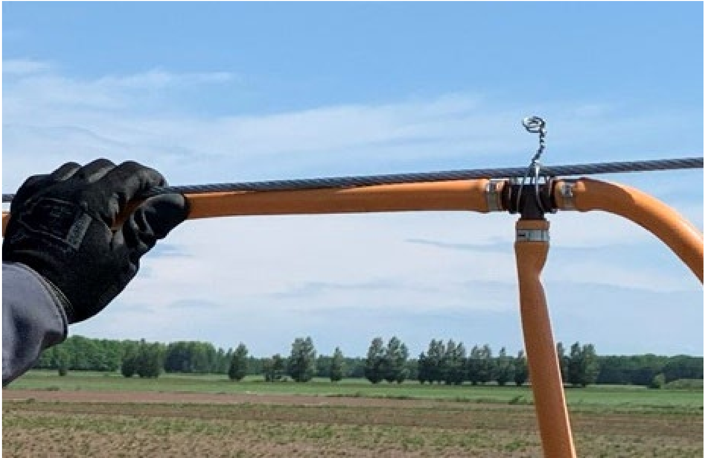
Figure 18. Montage final de la ligne secondaire d'eau sur le câble d'acier (connecteur T à insertion).
