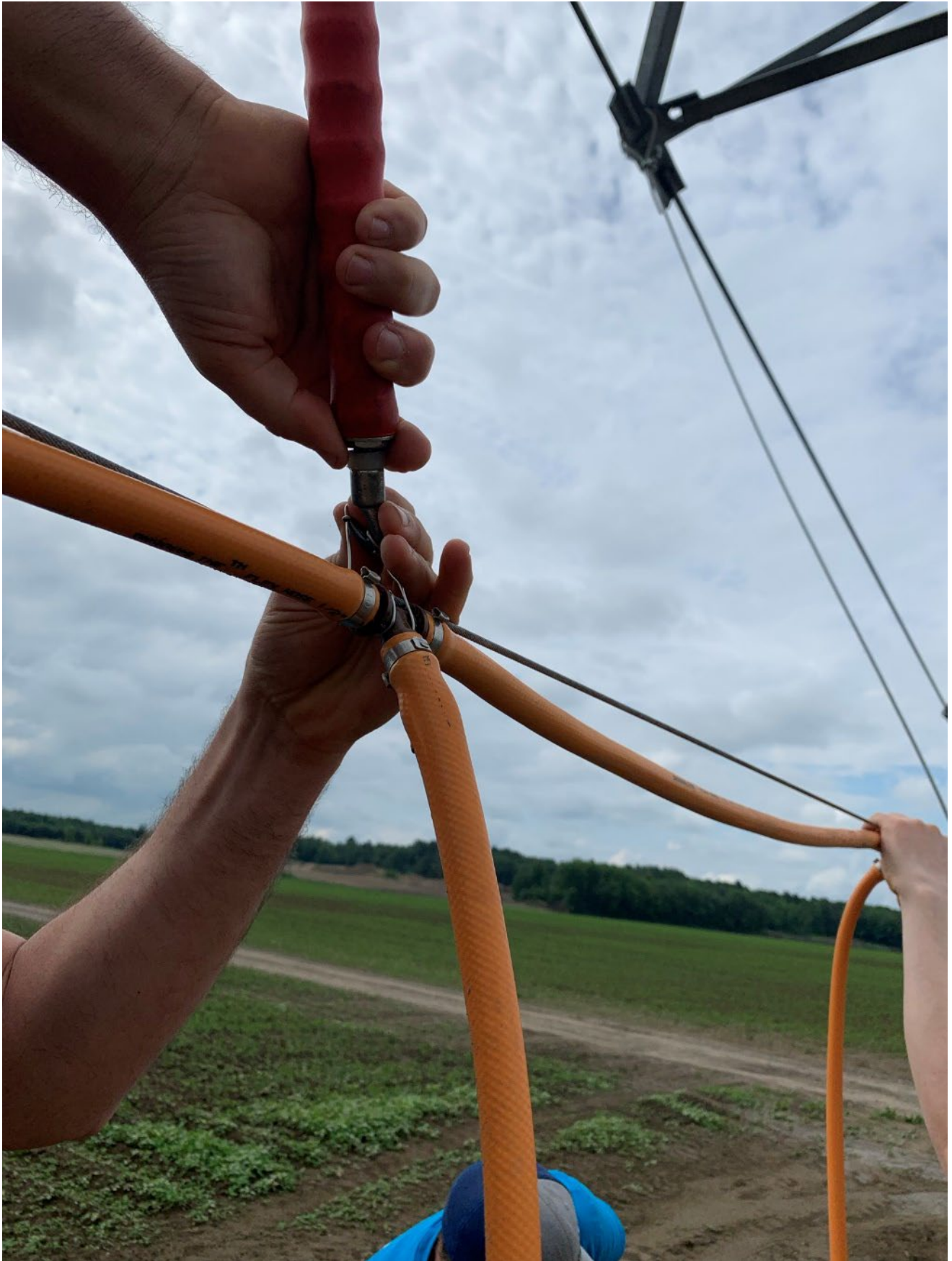
Figure 17. Installation de la ligne secondaire d'eau sur le câble d'acier (T à insertion) à l'aide de broches à enrouler.
